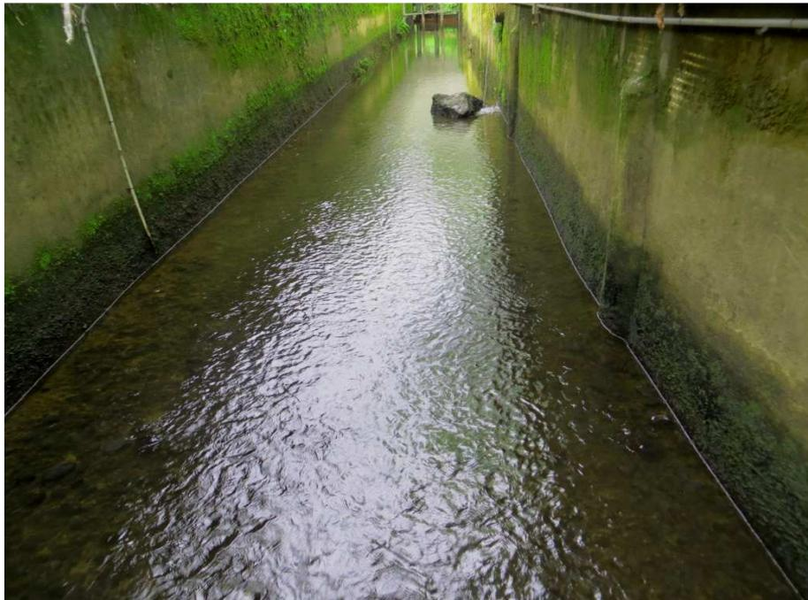
**Figura C.2.1.4.** Aspecto del canal de Ximonde tras su acondicionamiento. Se puede observar uno de los bloques instalados para proporcionar refugio.
