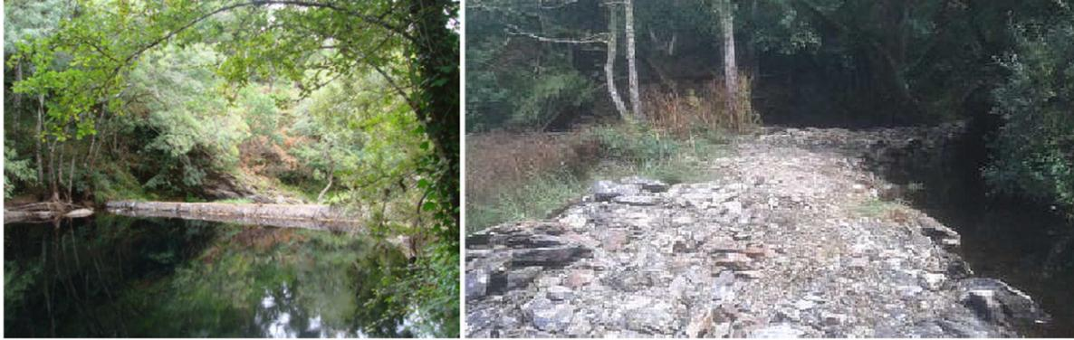
**Figura C.1.7.** Estado del obstáculo A-a (aguas arriba de Carmoega) antes (izquierda) y después de la actuación (derecha). Esta actuación hubo de detenerse por la fuerte oposición vecinal cuando sólo se había procedido al picado de la parte superior de hormigón.
